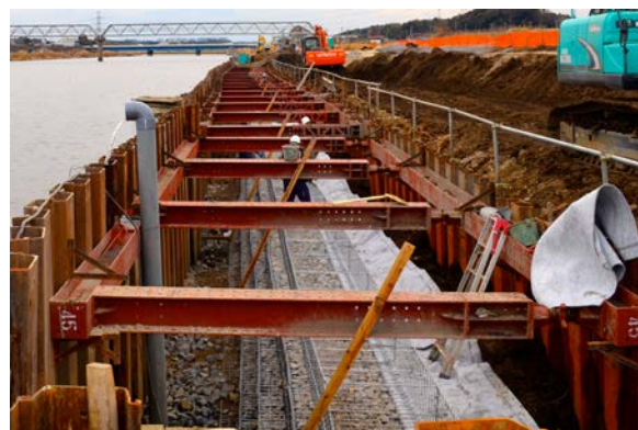
図 9 新川の工事現場
